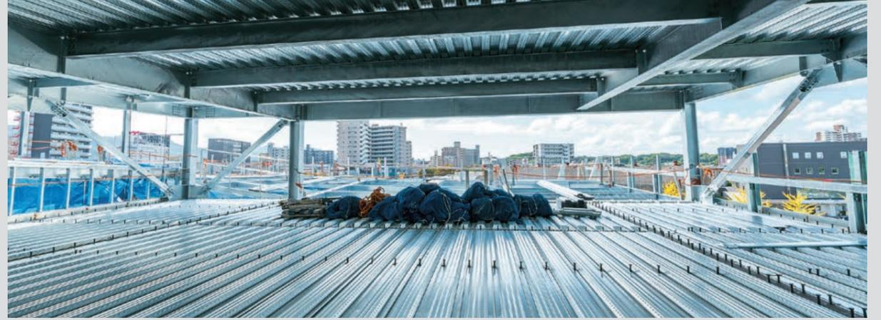
2024年9月下旬 スタッドボルトを打ち込んだデッキを撮影。この上にコンクリートを打設していく。
